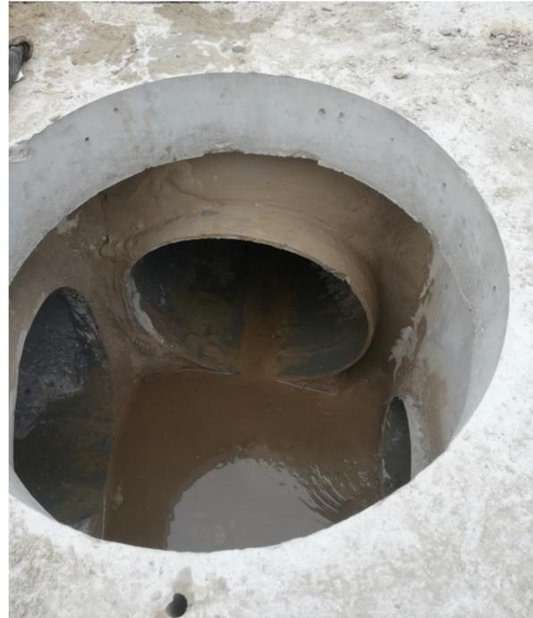
**-Rue de Saint Pol :** L'urgence du risque d'écroulement de la chaussée a conduit à la réfection de la conduite d'eau et de la voute à l'intersection avec la rue Podevin et la pose de nouveaux tuyaux.
